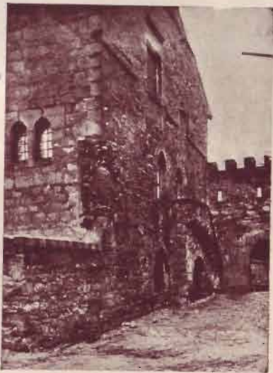
FUENTERRABIA.-CASA DE ECHEVESTE
